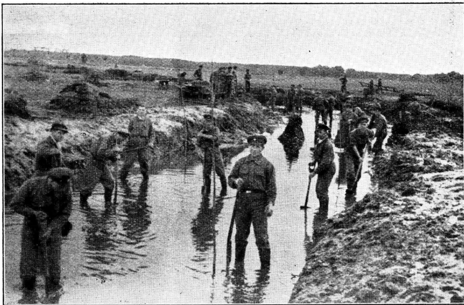
Das Flußbett wird vertieft und verbreitert.
